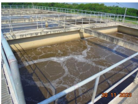
ภาพที่ (15) ระบบบำบัดน้ำเสีย (Equalization Tank)
